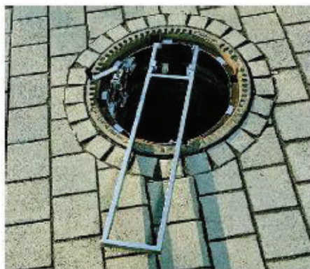
5. Provisorische Schachtabdeckung
